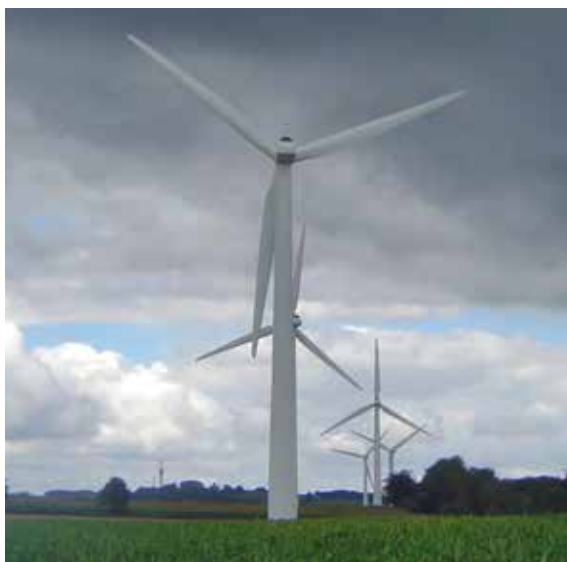
Parco eolico di proprietà dei cittadini Le Mene (Francia)
