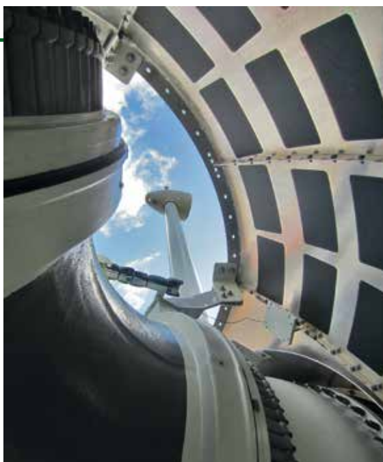
Manutenzione impianto eolico, progetto PSDT (Scozia)
