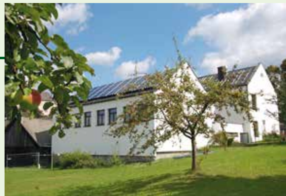
Impianto solare termico, scuola di Albrechtsberg (Austria)
