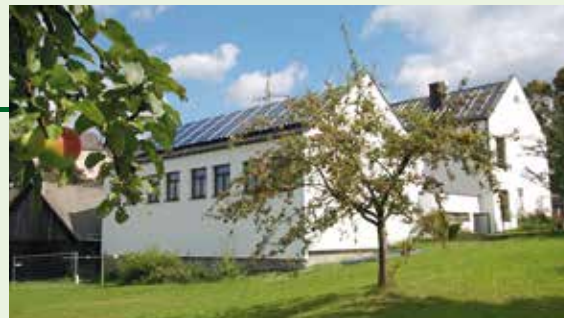
Izolatie termică, școala Albrechtsberg (Austria)
