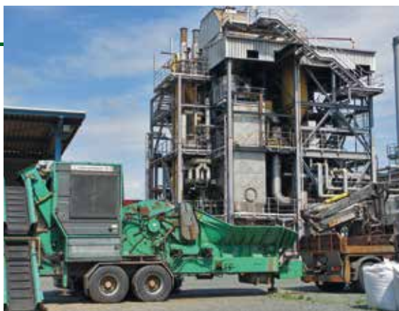
Centrală de gazeificare a biomasei, Güssing, (Austria)
