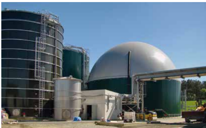
Unitate de biogaz teritorială și colectivă, Le Mené (Franța)
